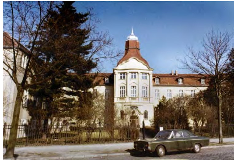
1918 kauften die Berliner Rotkreuzschwestern ihre erste Klinik – das Rittberg-Krankenhaus; 1995 wurde dieses geschlossen. Seit 2001 ist das Gebäude Sitz des DRK-Generalsekretariats.
